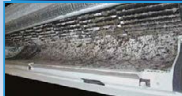
Турбіна настінного кондиціонера на якому знагодиться цвіль
