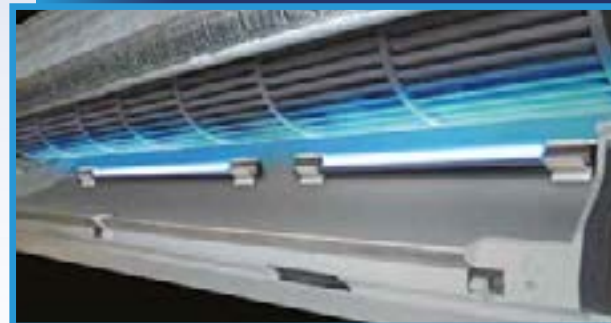
Turbina klimatyzatora naściennego z zainstalowanymi lampami UV
